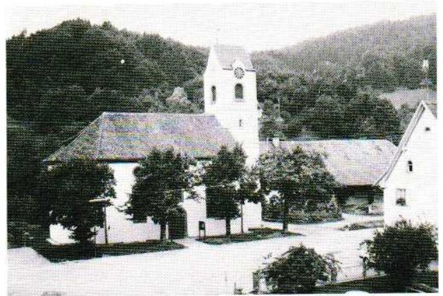
Außenansicht des renovierten Gotteshauses von 1982
