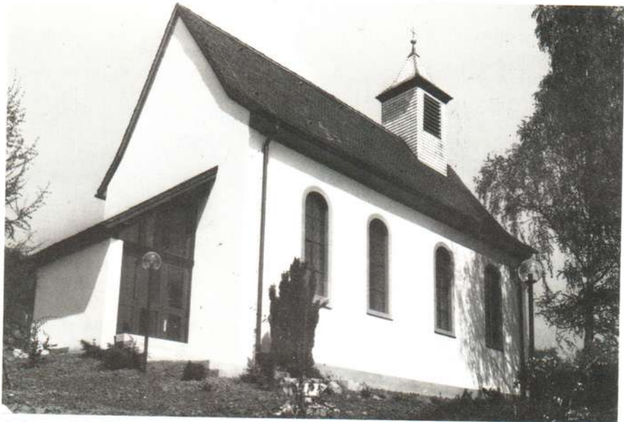
Außenansicht der renovierten Kirche
